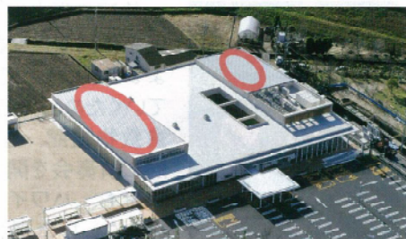
▲太陽光発電システムの設置場所
